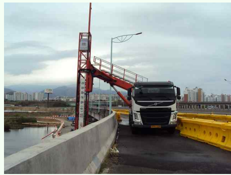
교량점검차를 이용한 하면 조사
