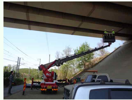
고소작업차를 이용한 하면 조사
