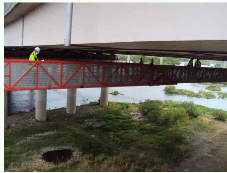
교량점검차를 이용한 하면 조사
